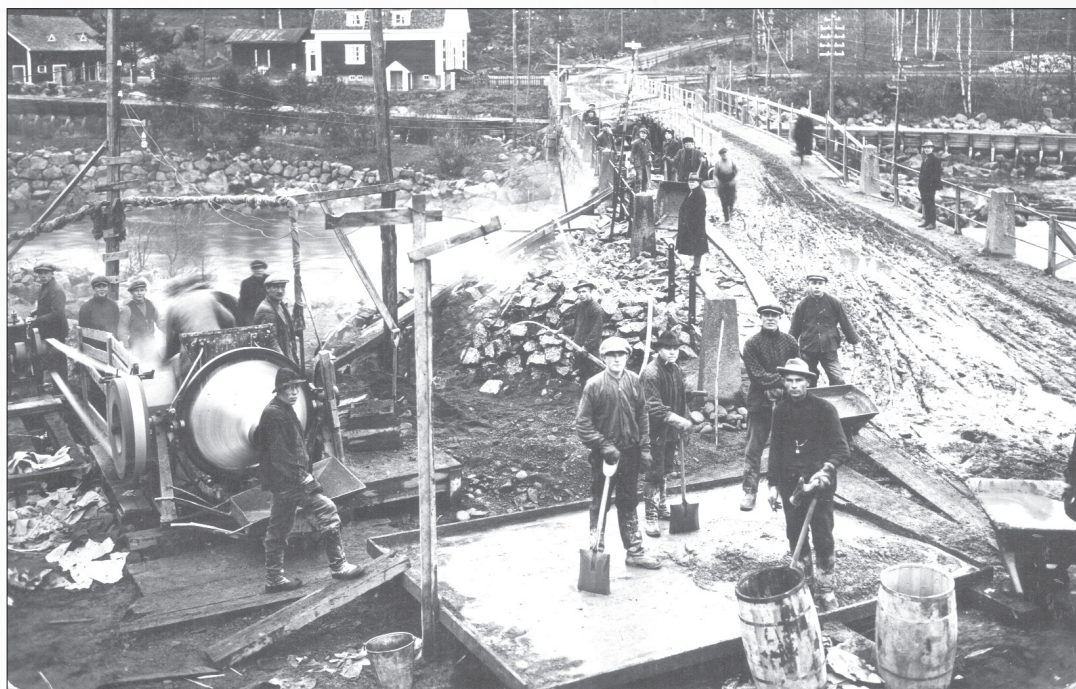
Siuronkosken silta peruskorjattiin vuonna 1926. Sateet eivät urakkaporukkaa hidastaneet.
